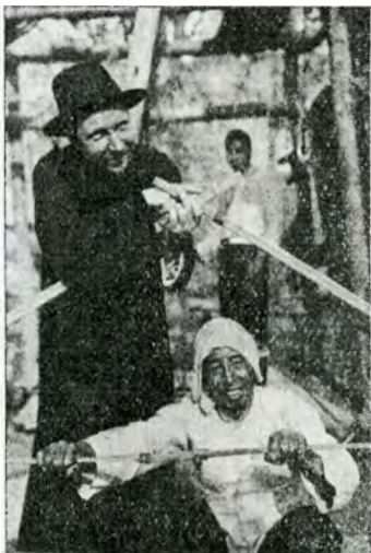
Linka bambusowa u góry wystająca ścianką, jako punkt zaczepienia, na dole połączenie za pomocą spojów metalowych
