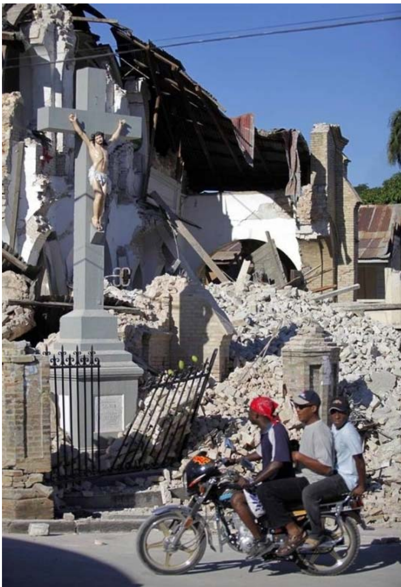
Ruiny katedry w Port-au-Prince, Haiti po trzesieniu ziemi. Przed katedrą ocalał nietknięty krzyż
