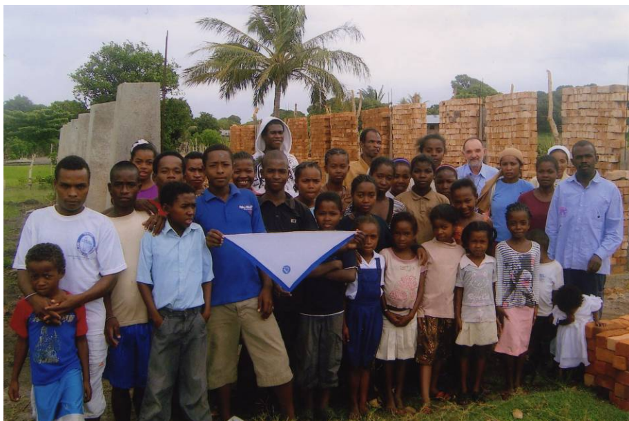
Budowa kościoła w Andramaka. Dziękujemy!
